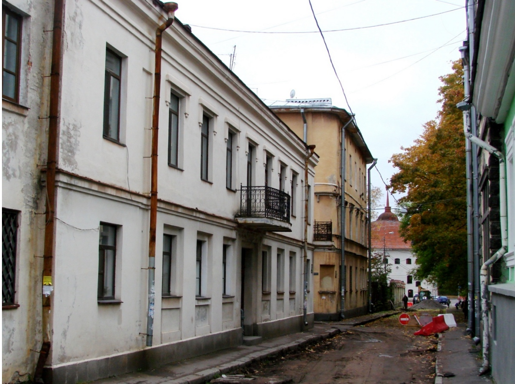
Karjaportinkatu 10:een vuonna 1993 rakennettu asuintalo toistaa ulkoasultaan sitä 1700-luvun asuintaloa, jonka jäänteet raivattiin pois 1950-luvulla, ja täydentää kadun rakennuskokonaisuutta. Valokuva vuodelta 2013.
