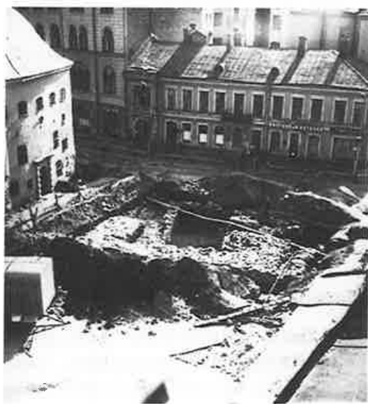
Kaivaustyöt Karjaportin barbakanin alueella.
