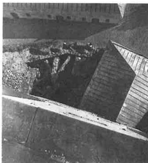
Kaivaustyöt Sepänpihan pohjoispuolella; näkymä Olavin tornista.
