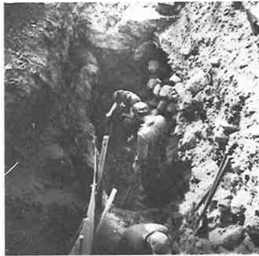
Kaivaustöitä vanhassa tuomiokirkossa v. 1986: 1700-luvun haudat rakennuksen "uudessa osassa".
