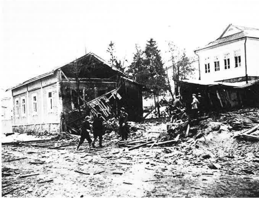
Kelkkalan kansakoulun kolmas (uusin) rakennus (rak. 1911) oikealla yläkulmassa. Talvisodan pommi on repäissyt saunan ja pesutuvan päätyä.
