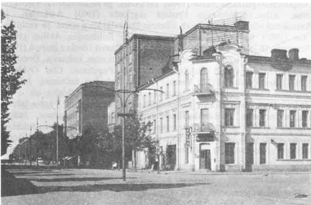
Karjalankadun ja Salakkalahdenkadun kulma.
