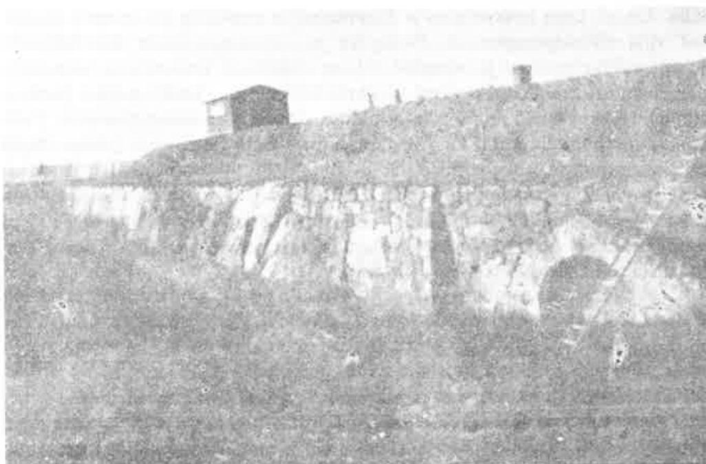
Suojakammioiden suut linnake C:n oikealla siivellä uloshyökkäysaukiosta katsottuna.
