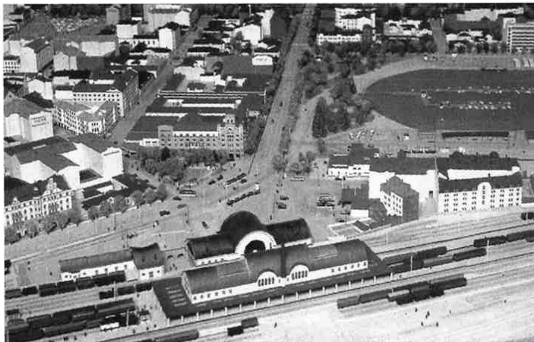
Rautatieasema Papulan puolelta katsottuna: etualalla odotus- ja ravintolasalit ympärillään kalettua laiturialuetta, Asematorin puolella päähalli toimistoineen. Asematorilta suuntautuu kolme pääkatua: Karjalankatu keskellä, Repolankatu Kolmikulmapuistikon sivuitse vasemmalle ja Rautatienkatu etualalla vasemmalle.
