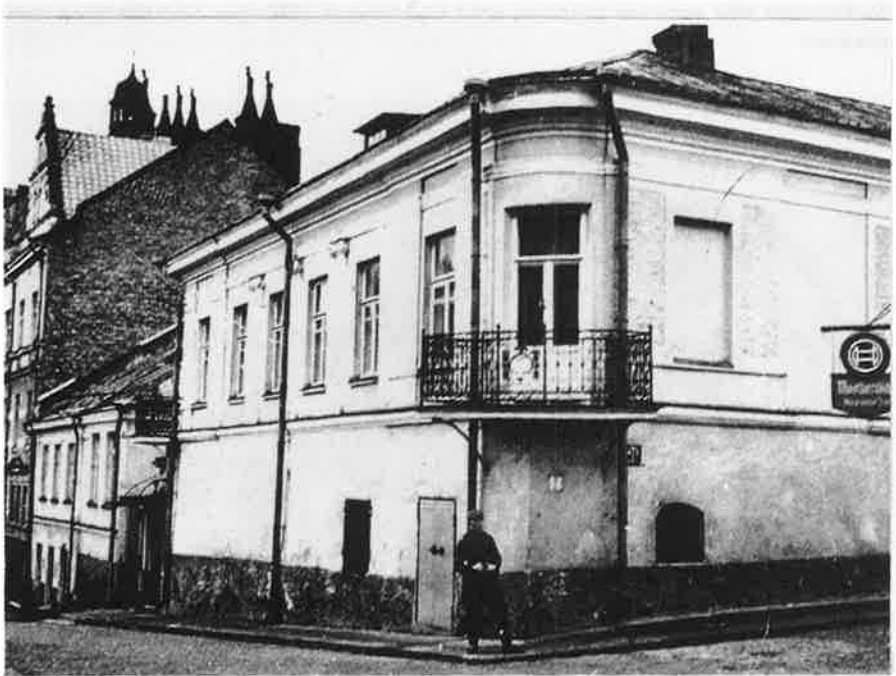
Wahlin talo Linnankadun ja Vesiportinkadun kulmassa tontilla 18.
