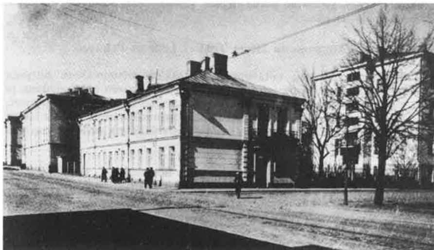
Lääninsairaalan rakennuksia Kannaksenkadun varrella (valok. Museovirasto).
