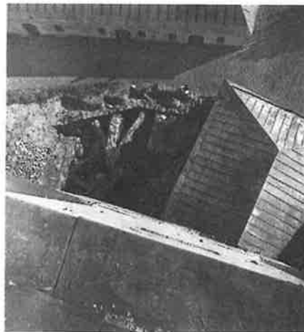
Kaivaustyöt Sepänpihan pohjoispuolella; näkymä Olavin tornista.
