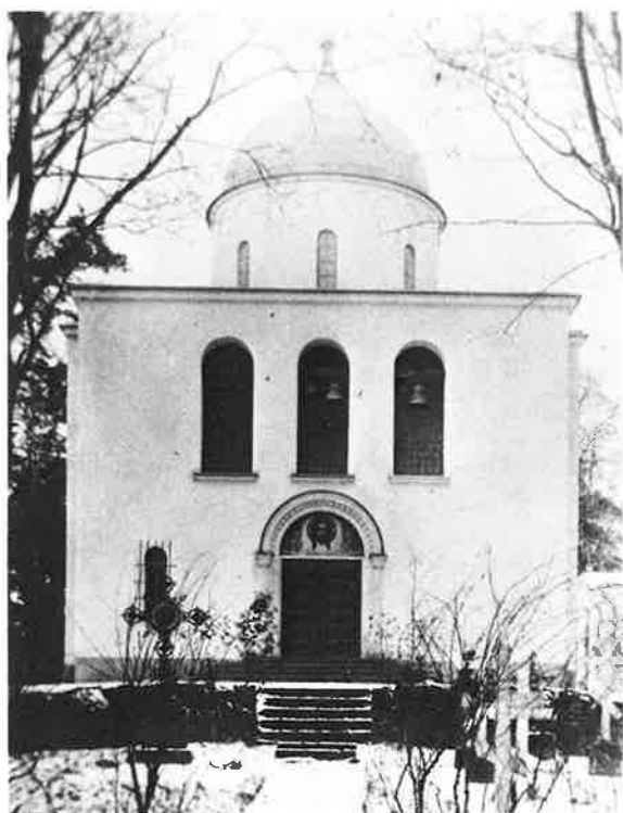
Vuonna 1936 valmistunut "Kaikkien pyhien kirkko"
