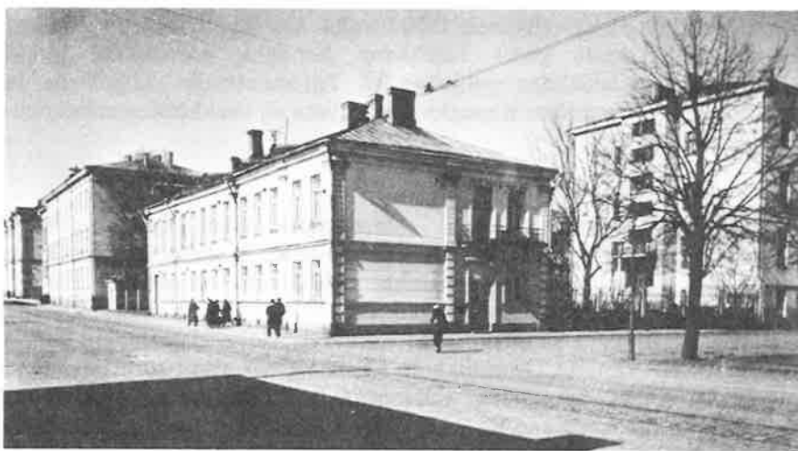
Lääninsairaalan rakennuksia Kannaksenkadun varrella.
