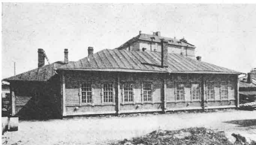
Pantsarlahden ammattikoulun luokahuonerakennus.
