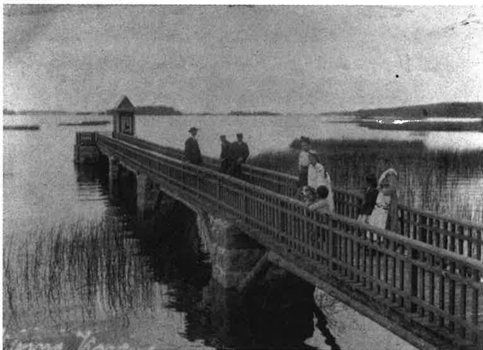
Rantalan kesäkodin pitkä laituri.
