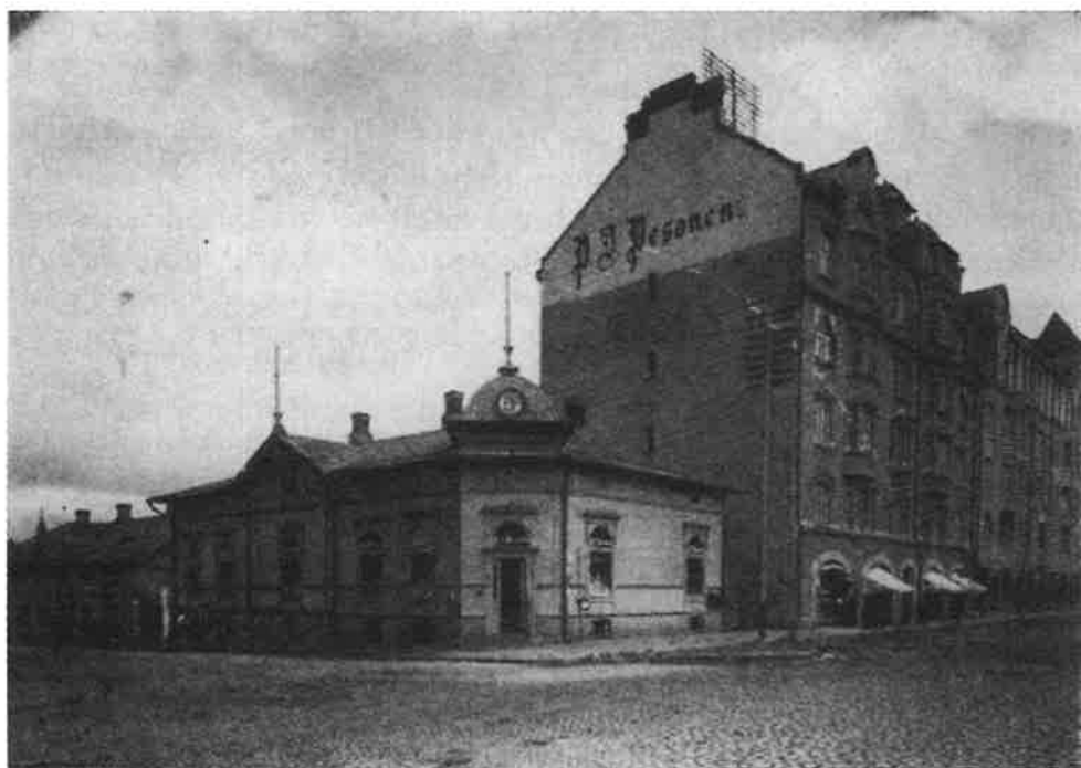
Tukkukauppias P.J.Pesosen viisikerroksinen asuin- ja liiketalo Pietarinkatu 10 valmistui vuonna 1904. Jugend-julkisivuisen rakennuksen oli piirtänyt arkkitehti Emil Bertel Mauritz Mohell. Pesosen toinen talo, Paavo Uotilan suunnittelema Pietarinkatu 12, on vuodelta 1907. Pietarinkadun ja Karjalankadun kulmassa näkyvä puutalo rakennettiin v. 1902 ja toimi sekatavarakauppana. Sen vieressä Karjalankadulla näkyy Pesosen kangaskauppa.
