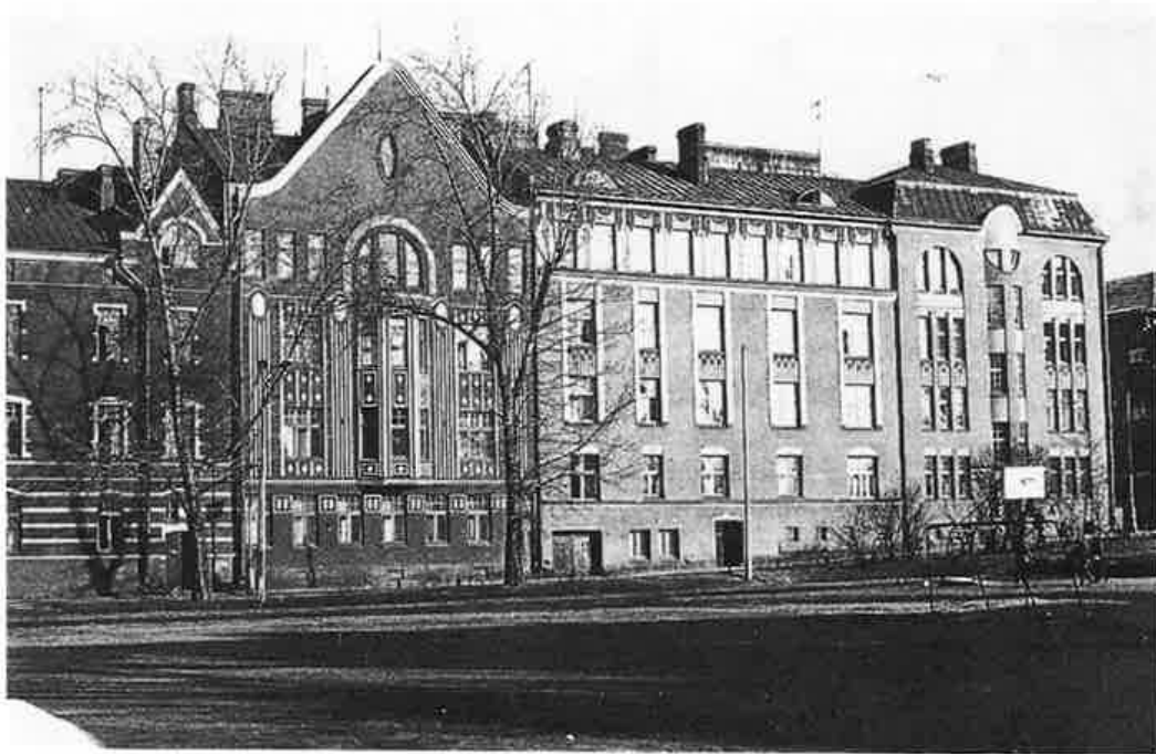
Vaasankadun alkupäättä (luettelon n:ot 5, 65 ja 59).
