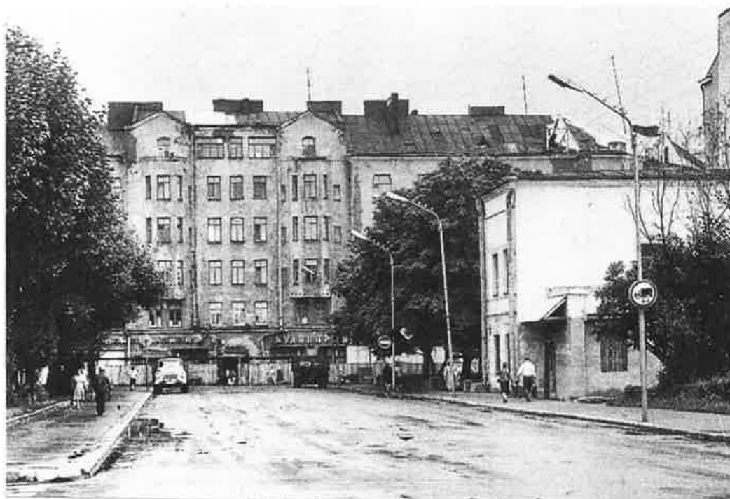
Kannaksenkadun alkupäätä Repolankadulta katsottuna ennen sotia ja nyt (luettelon n:o 28).
